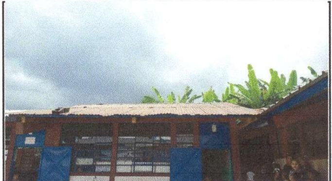
CUBIERTA DE LAMINA. Módulo 2 Aula 1
