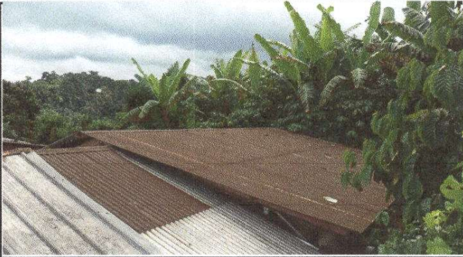
CUBIERTA DE LAMINA. Módulo 1 Aula 1
