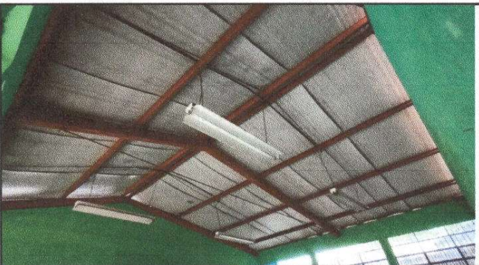
REPARACION DEL SISTEMA ELECTRICO. Aula 1 Módulo 2
