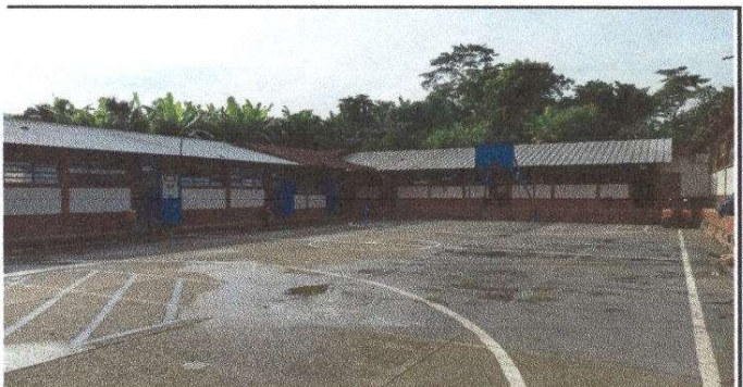
MODULOS DE AULAS 1Y 2. Pintura de interiores y exteriores.
