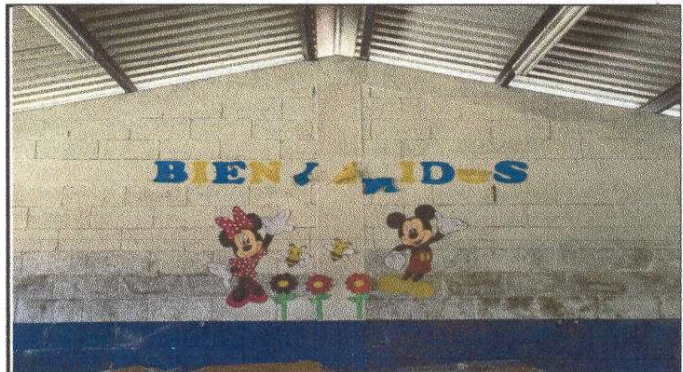
REPARACION DE SISTEMA ELECTRICO Y REPELLO DE MURO. Aula 2 Módulo 1
